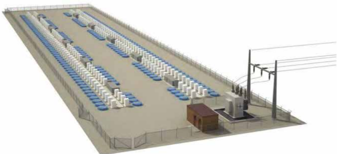
Figur 4.19. Koppling av svänghjulsverk till transmissionsnätet [28].
